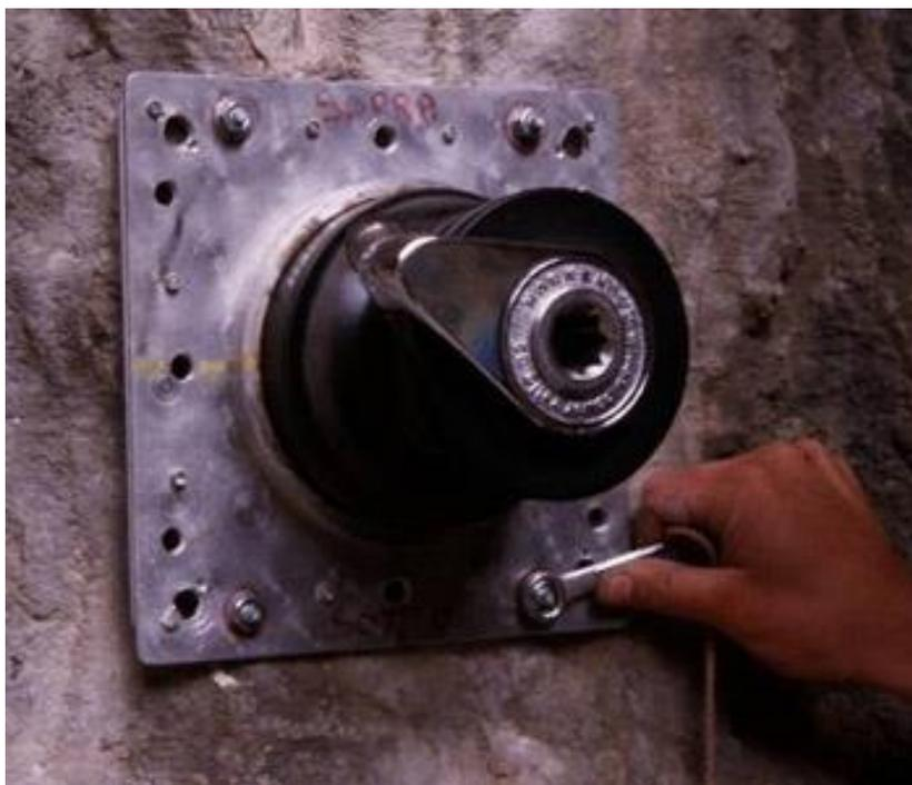
Noi ne mettiamo di solito quattro in tutto, in corrispondenza degli angoli delle piastre (vedi foto a destra). Per questa operazione occorrono complessivamente dai 5 ai 10 minuti e si mette in opera un sistema di facile recupero (un solo operatore può recuperare fino a 400 kgp) ed ha una resistenza superiore ai 3000 kgp, in tutte le direzioni di trazione.
